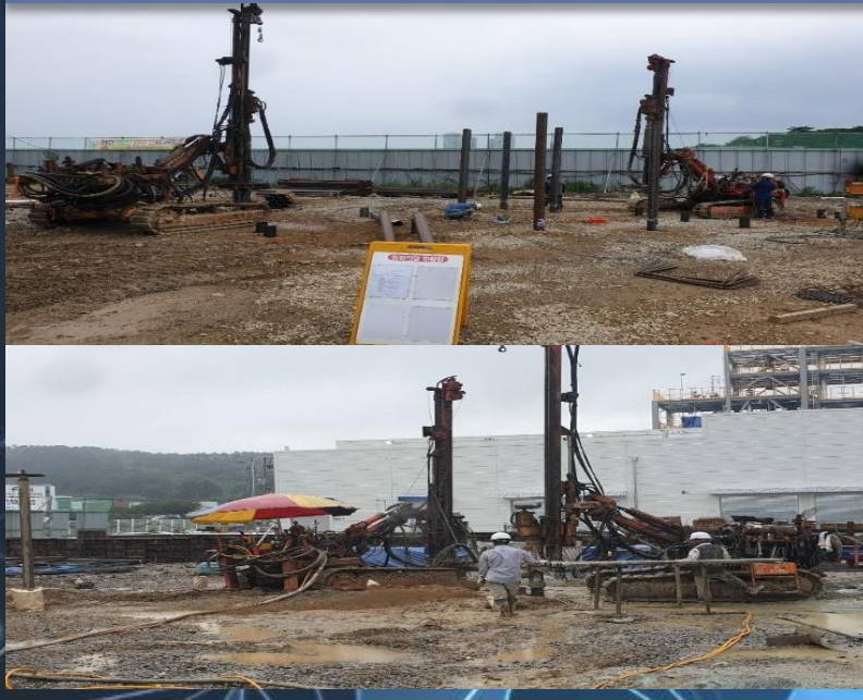
원익 머트리얼즈 오창 증축공사
