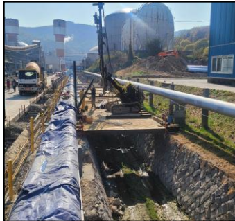
A PILE 공사
