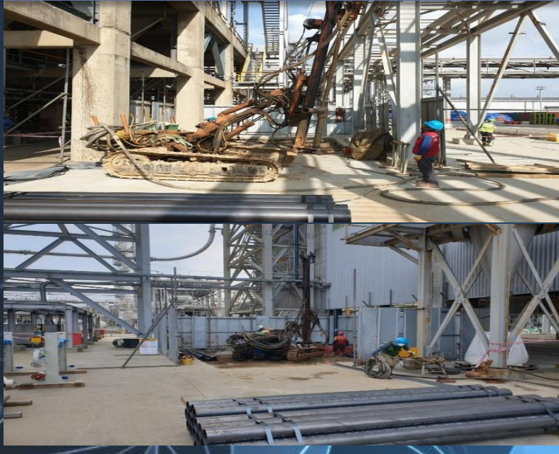
LG화학 OXO SRU NH3 SCRUBBER 토목공사
