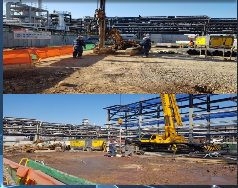
SK에너지 울산 공장 S-PROJECT 중 PUMP FOUNDATION
