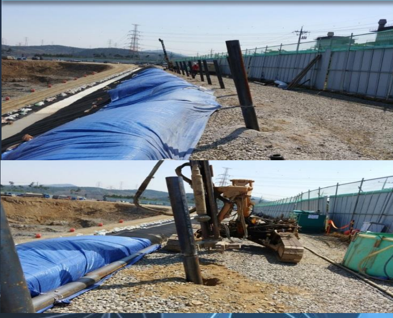
서산 오토밸리 폐기물처리시설 신축공사
