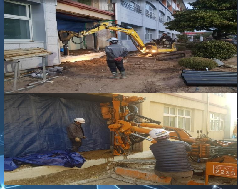
경주 선덕여자고등학교 내진보강공사
