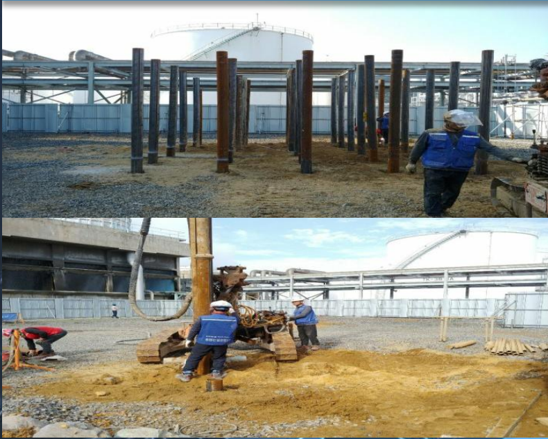
여수 롯데케미칼 4EOA PROJECT
