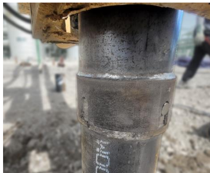
원터치 케이싱 커플러 조립 모습 (조립 이후 해체 불가)
