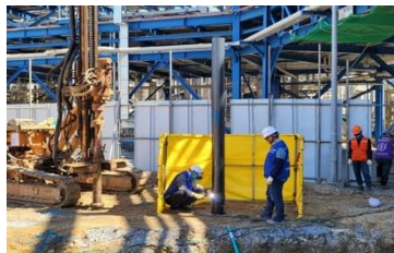
용접작업 시 불티방지막, 화기감시자 배치
